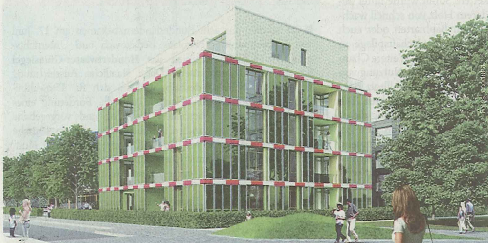
An Fassaden erzeugen Algen in Photobioreaktoren Wärme für das ganze Haus.
